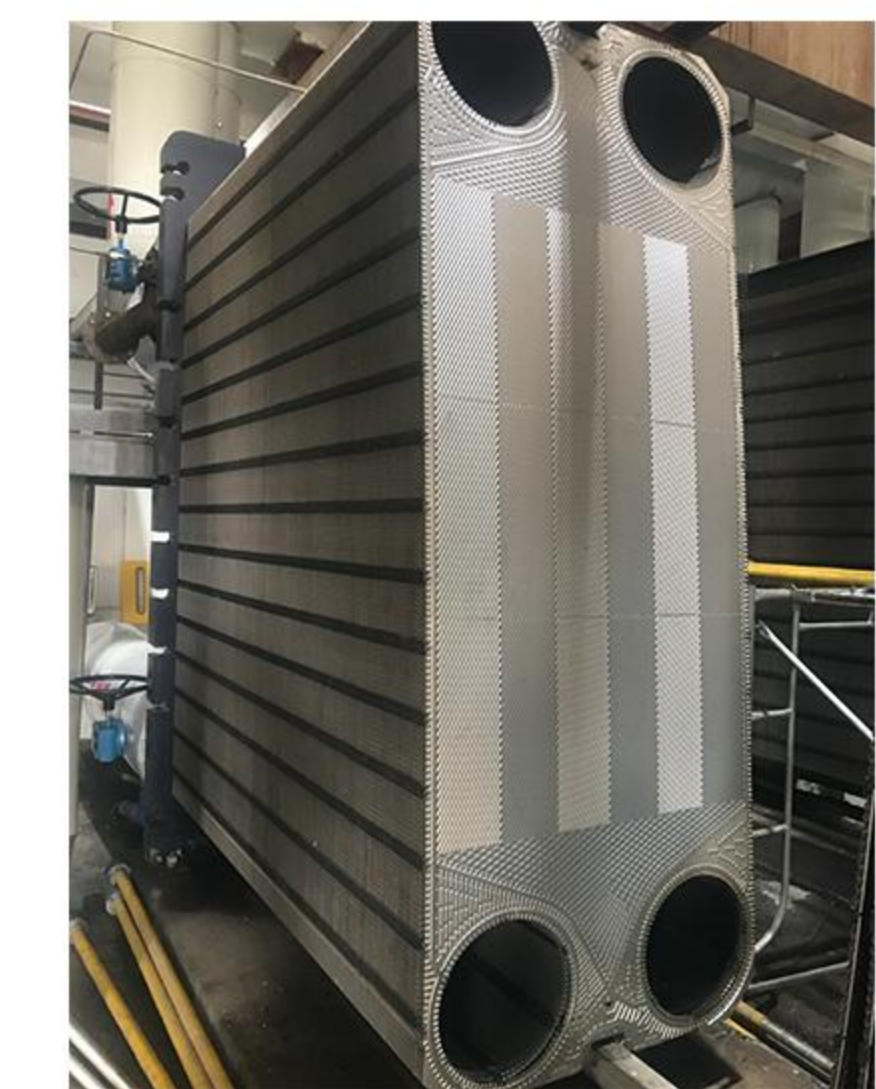
大型隔压站清洗后
