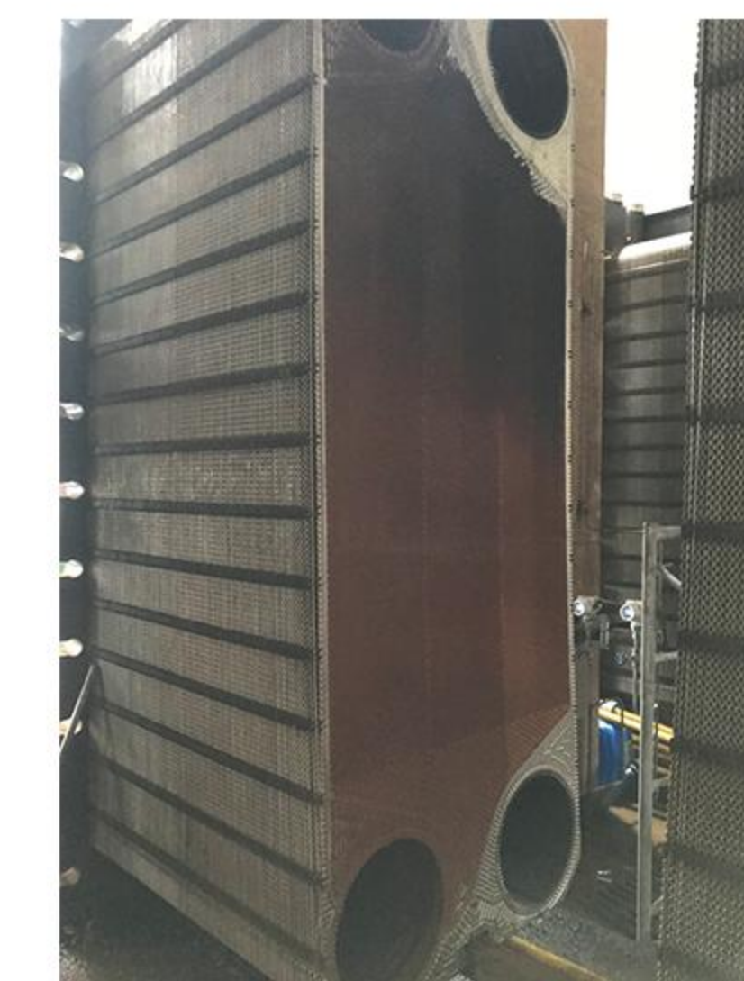
大型隔压站清洗前
