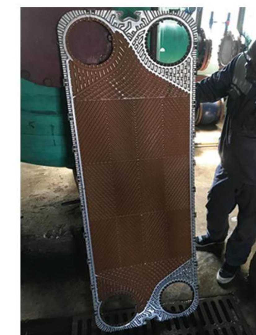
二级换热站清洗前
